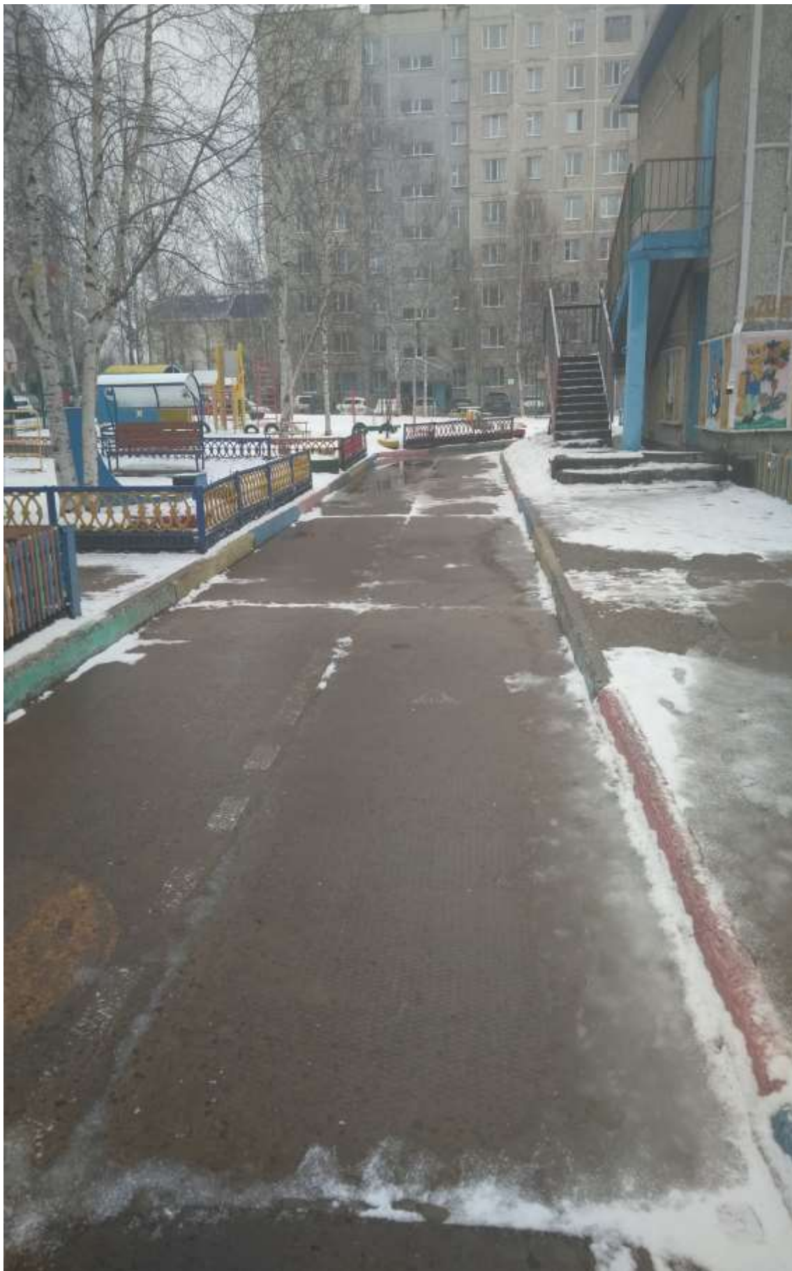
Фото 2 Территория, прилегающие к объекту: пешеходные пути по территории ДОУ
